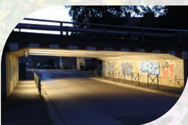
Nouvel éclairage public
