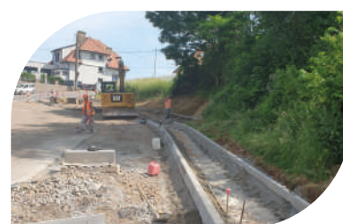
Création d'un nouveau parking
