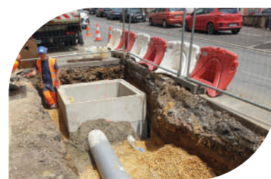
Rénovation de réseaux d'assainissement
